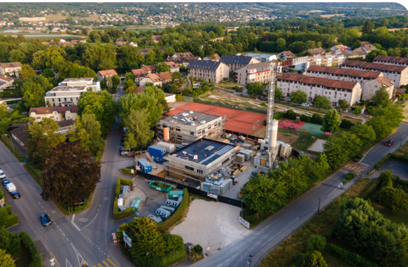
Chantier de la nouvelle zone sportive.
