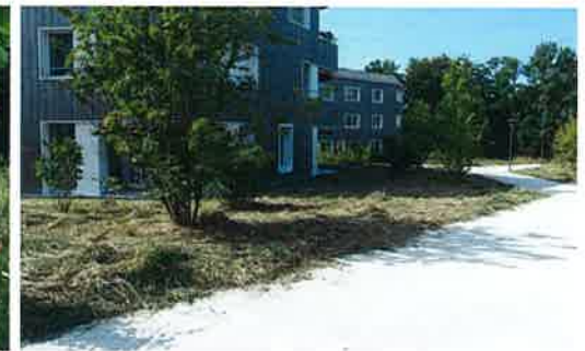
Cheseaux-sur-Lausanne, pour la SCHL aménagements extérieurs : bureau Jean-Jacques Borgeaud source image : bureau Jean-Jacques Borgeaud
