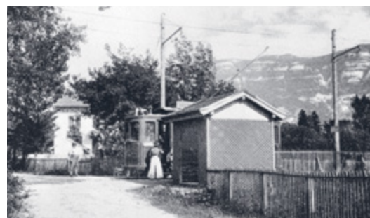
Station du tram au ch. de la Fondelle.
