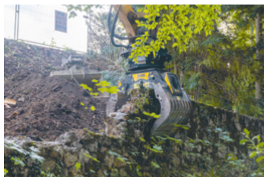
La démolition des murs de rétention, pour la renaturation du lit de la rivière.
