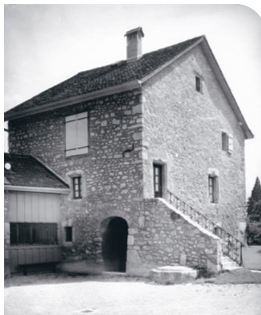
Le bâtiment de l'ancienne cure.
