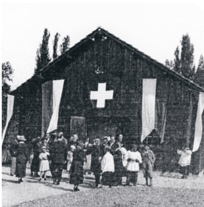
La salle paroissiale construite derrière la chapelle.
