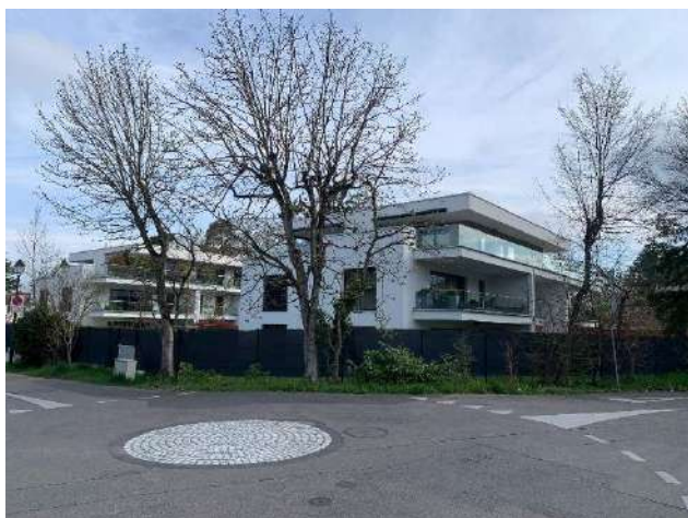
Image de référence, réalisation en zone 5 à Troinex, chemin Lullin 7 (intersection avec chemin de la Fondelle)
